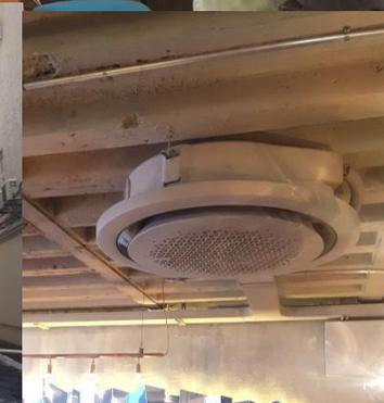
В ресторане установлены кассетные внутренние блоки 360, Обеспечивающие охлаждение и обогрев залов с помощью наружного блока серии DVMS Eco.
