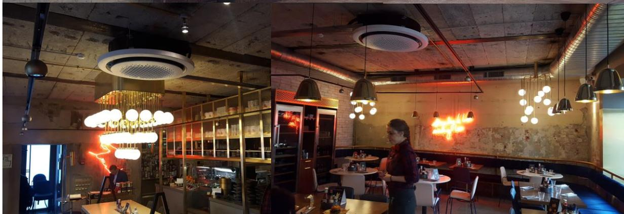
В ресторане установлены кассетные внутренние блоки 360, Обеспечивающие охлаждение и обогрев залов с помощью наружного блока серии DVMS Eco.
