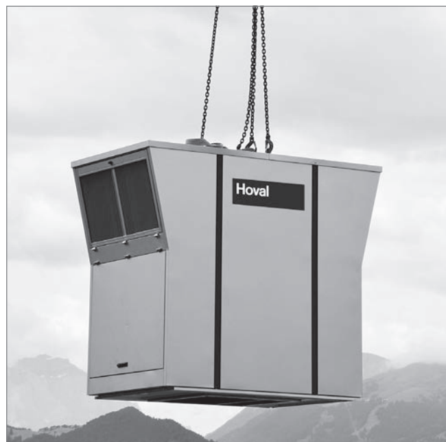
Табл. F8: Подъем верхнего блока с использованием рым-болтов
