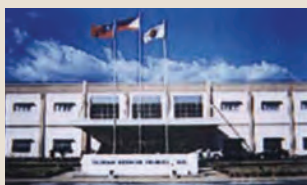
Hitachi Air Conditioning, Филиппины
