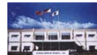
Hitachi Air Conditioning, Филиппины
