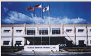
Hitachi Air Conditioning, Филиппины
