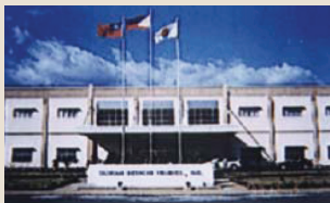
Hitachi Air Conditioning, Филиппины
