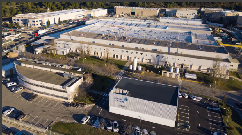
Завод по производству VRF Hitachi в Барселоне (Испания)
