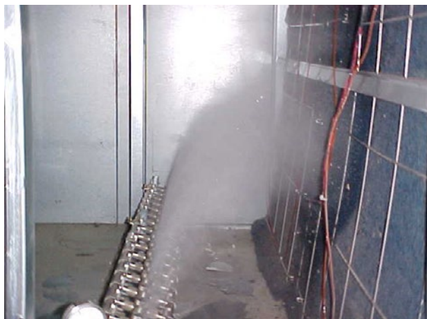
Рис. 4.16 Размещение распылительных форсунок в центральных кондиционерах
