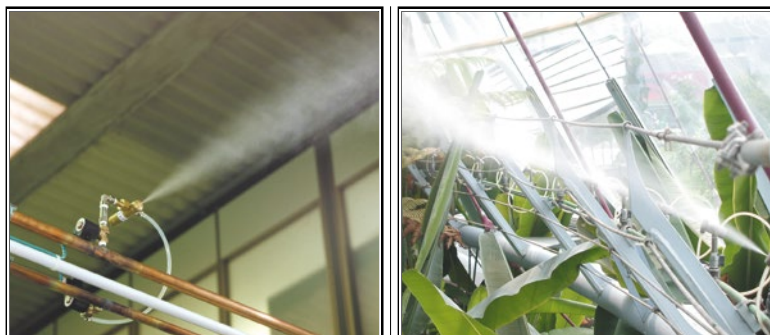
Рис. 4.14 Размещение распылительных форсунок в увлажняемом помещении
