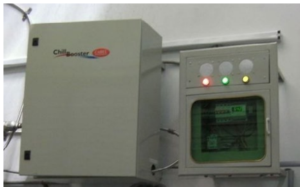
Рис. 11.8 Распылительный увлажнитель среднего давления в процессе работы
