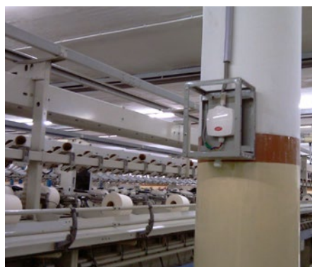
Рис. 11.7 Датчик влажности, установленный на стене
