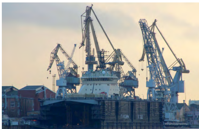
Адмиралтейские верфи, г. Санкт-Петербург Вентиляционные агрегаты
