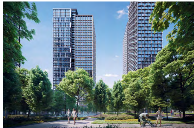
ЖК PRIME PARK, г. Москва Мультизональные системы Hitachi
