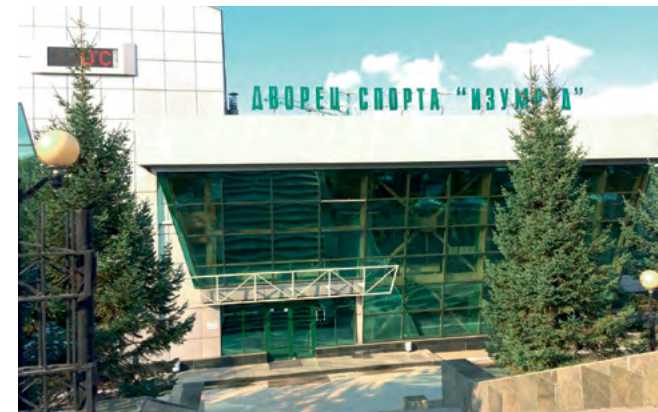
Бассейн «Изумруд» г. Иркутск Вентиляционные установки для бассейна Dantherm
