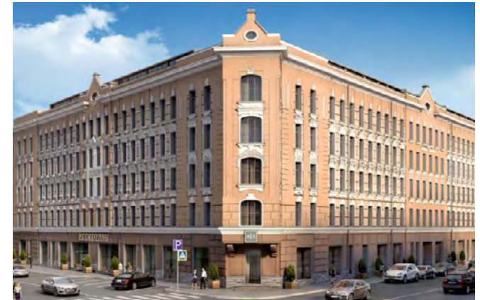
ЖК «Project 613», г. Санкт-Петербург Мультизональные системы Hitachi
