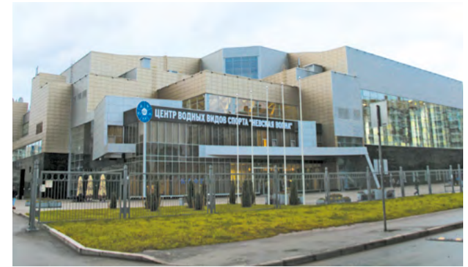
Центр водных видов спорта «Невская волна», г. Санкт-Петербург. Вентиляционные установки для бассейна
