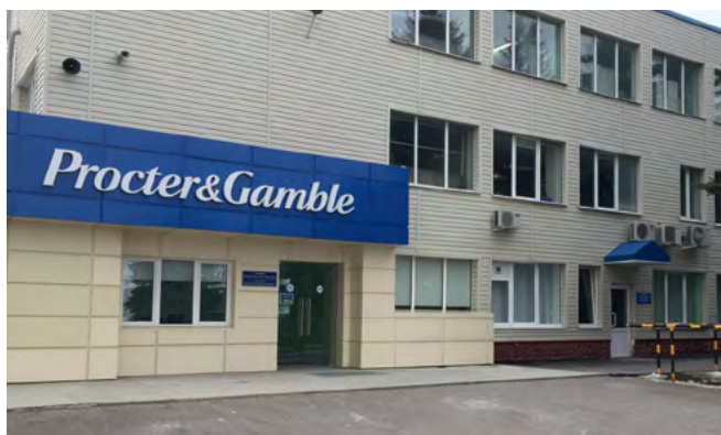
Производственные помещения компании Procter&Gamble, Московская обл. Вентиляционные агрегаты
