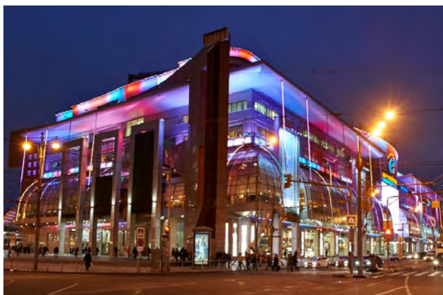
Торгово-Развлекательный центр Европейский, г. Москва Мультизональные системы
