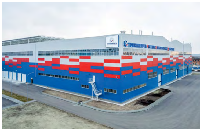
АО «РЭД» Транснефть, г. Челябинск Прецизионные кондиционеры
