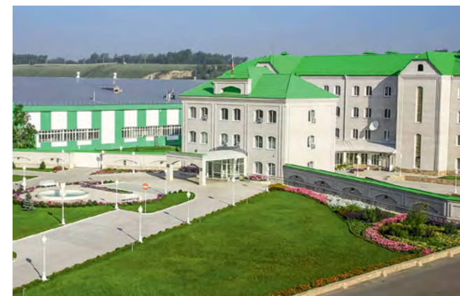
Фармацевтический завод «Эвалар», г. Бийск Адсорбционные осушители
