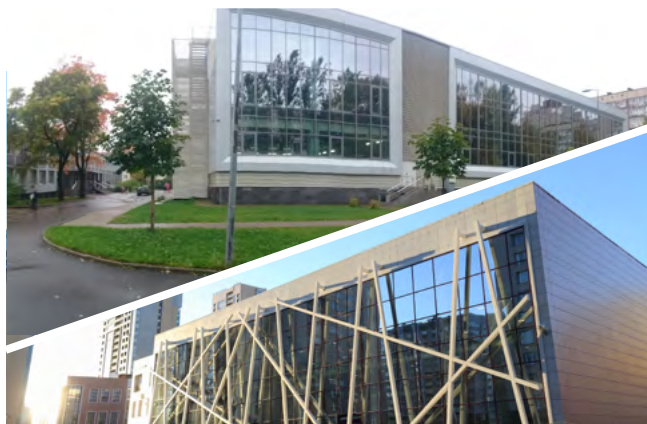
ГБОУ СОШ №305, 777, г. Санкт-Петербург Вентиляционные установки для бассейна Dantherm
