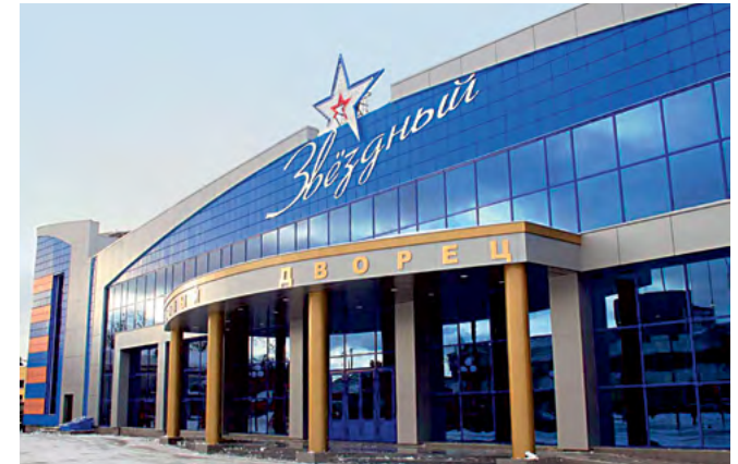
Ледовый дворец «Звёздный» г. Оренбург Вентиляционные агрегаты
