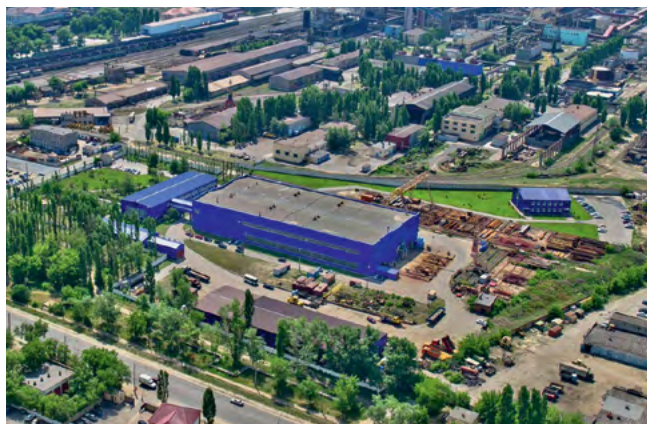
Новолипецкий металлургический комбинат, г. Липецк Мультизональные системы Hitachi
