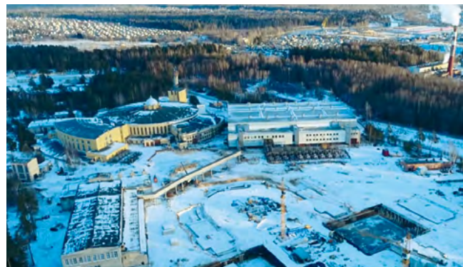
Объединённый институт ядерных исследований (ОИЯИ), Тяжелоионный коллайдер NICA, г. Дубна Прецизионные кондиционеры
