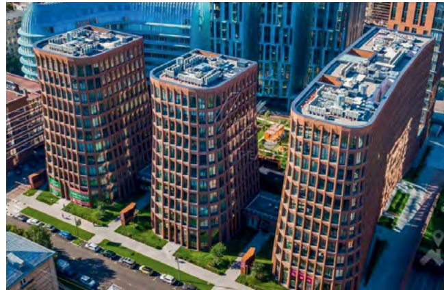
Элитный жилой комплекс «Садовые кварталы», г. Москва Мультизональные системы Hitachi
