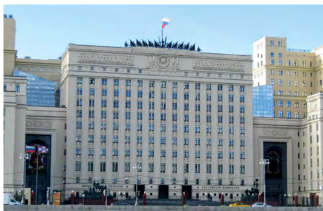
Комплекс Министерства обороны на Фрунзенской набережной, Москва Прецизионные кондиционеры, мультизональные системы, чиллеры
