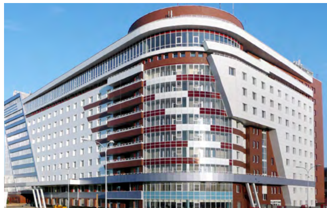
Фитнес-клуб на территории Гранд Отеля «Ока» г. Нижний Новгород Вентиляционные установки для бассейна Dantherm
