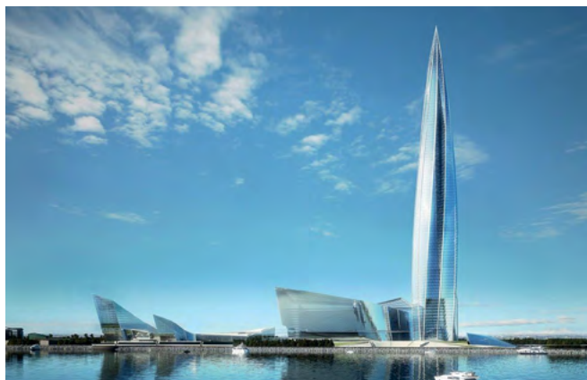
Лахта Центр, г. Санкт-Петербург Фэн-койлы, увлажнители, мультизональные системы Hitachi
