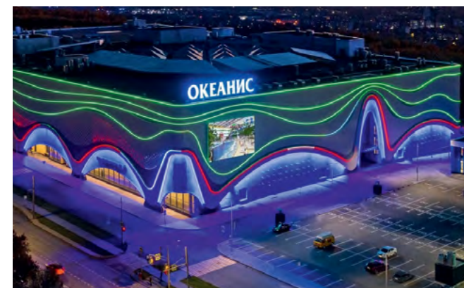
Многофункциональный комплекс «ОКЕАНИС», г. Нижний Новгород Вентиляционные установки для бассейна Dantherm, чиллеры,
