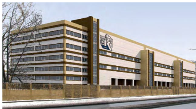
«ФГУП «Крыловский государственный научный центр», Санкт-Петербург Вентиляционные агрегаты, адсорбционные осушители
