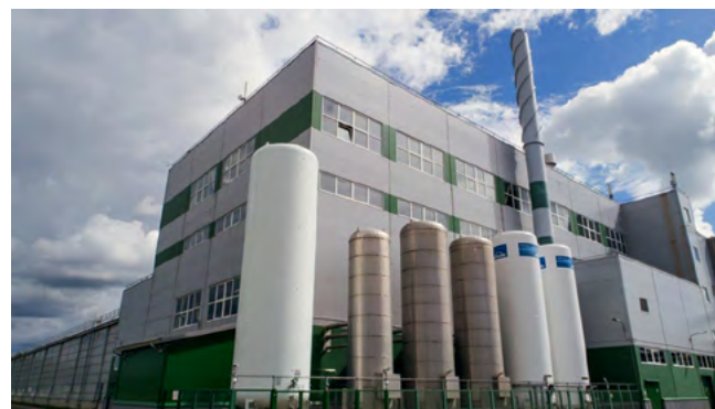
«ЛТ Крес Нева», производственный корпус по производству нетабачных компонентов, Ленинградская область Вентиляционные установки
