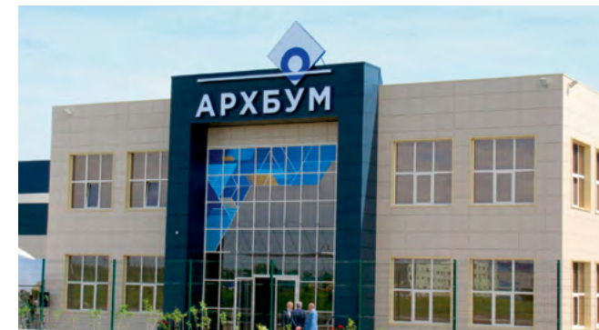
Производственные и складские помещения компании «Архбум», Калужская обл. и Московская обл. Мультизональные системы Hitachi, вентиляционные агрегаты
