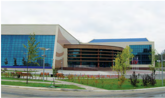
Спортивный комплекс «Озеро Круглое», Московская обл. Вентиляционные установки для бассейна Dantherm, вихревые воздухораспределители
