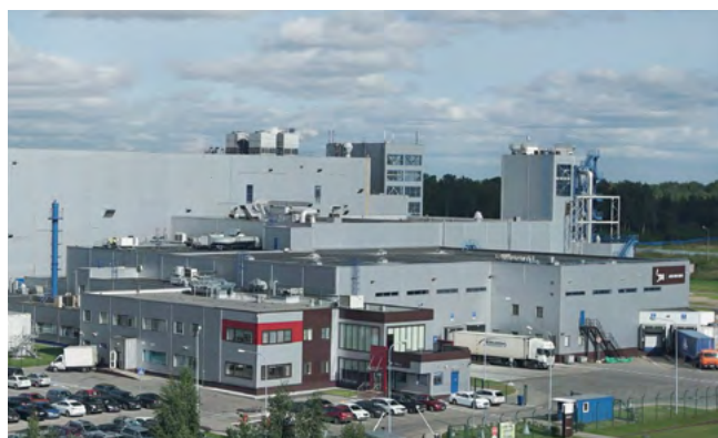
Завод «ЯКОБС ДАУ ЭГБЕРТС РУС», г. Санкт-Петербург Мультизональные системы Hitachi, чиллеры, конденсаторы
