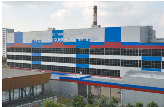
СЗРЦ «Алмаз-Антей», г. Санкт-Петербург Вентиляционные агрегаты
