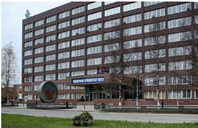
Административное здание ООО «Газпром трансгаз Ухта», г. Ухта Мультизональные системы
