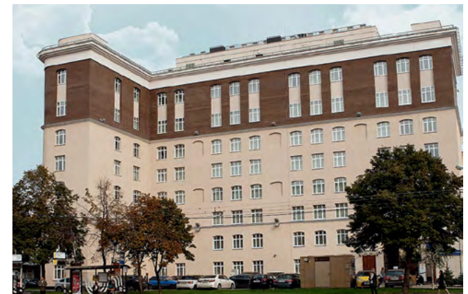
Архив внешней политики МИД РФ, г. Москва Вентиляционные агрегаты
