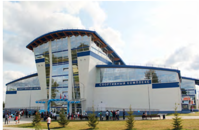
ФОК «Ленинское», Тульская обл. Прецизионные кондиционеры
