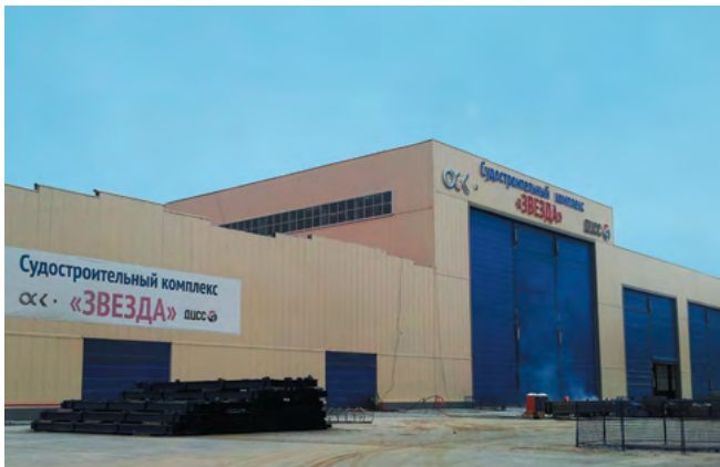
Судостроительный завод «ЗВЕЗДА» г. Владивосток Вентиляционные агрегаты
