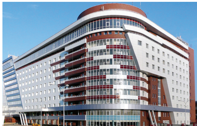
Фитнес-клуб на территории Гранд Отеля «Ока» г. Нижний Новгород Вентиляционные установки для бассейна Dantherm
