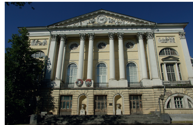
Главный военный клинический госпиталь им. Н. Н. Бурденко, г. Москва Мультизональные системы Pioneer
