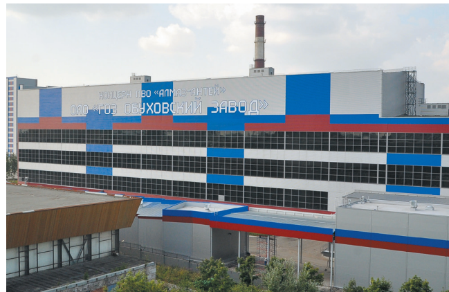
СЗРЦ «Алмаз-Антей», г. Санкт-Петербург Вентиляционные агрегаты
