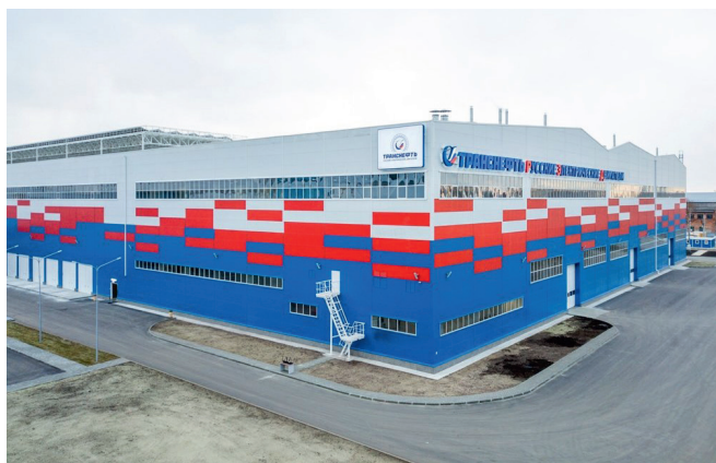
АО «РЭД» Транснефть, г. Челябинск Прецизионные кондиционеры
