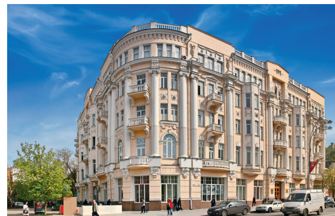
Южный Федеральный Университет г. Ростов-на-Дону Вентиляционные установки для бассейна Dantherm
