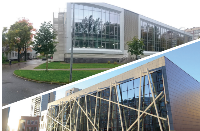
ГБОУ СОШ №305, 777, г. Санкт-Петербург Вентиляционные установки для бассейна Dantherm
