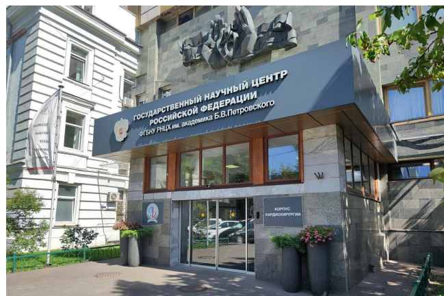
Российский научный центр хирургии им. академика Б.В. Петровского, г. Москва Мультизональные системы Hitachi, сплит-системы
