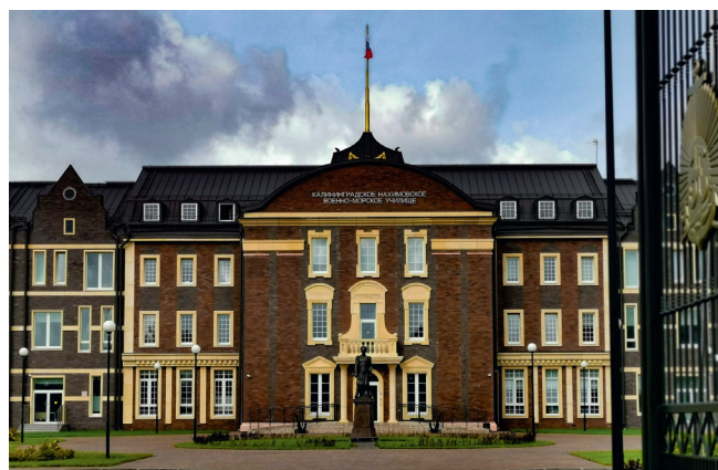
Нахимовское военно-морское училище, г. Калининград Сплит-системы
