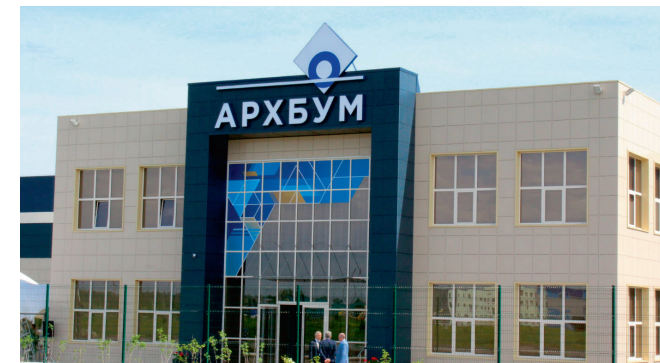
Производственные и складские помещения компании «Архбум», Калужская обл. и Московская обл. Мультизональные системы Hitachi, вентиляционные агрегаты
