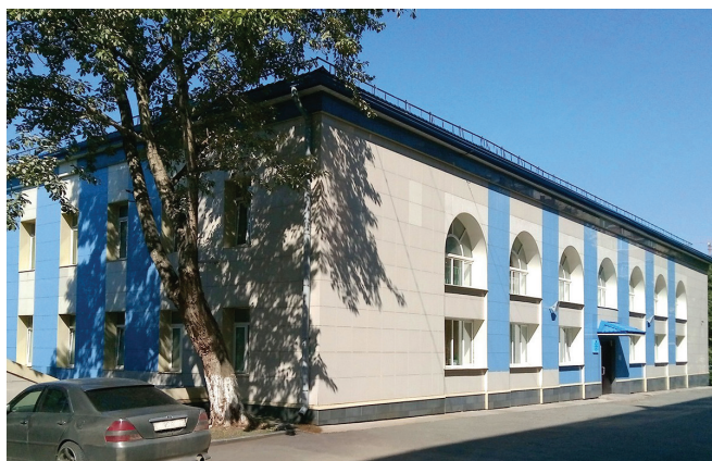
Бассейн «Морского Государственного университета им. адм. Г.И. Невельского», г. Владивосток Вентиляционные установки для бассейна Dantherm
