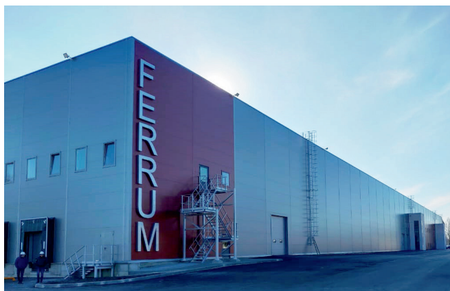
Завод металлоконструкций Ferrum, г. Воронеж Рециркуляционные агрегаты
