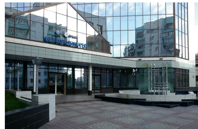
Административное Здание Центра управления се- тьми МРСК Центра «Белгородэнерго», г. Белгород Мультизональные системы Hitachi
