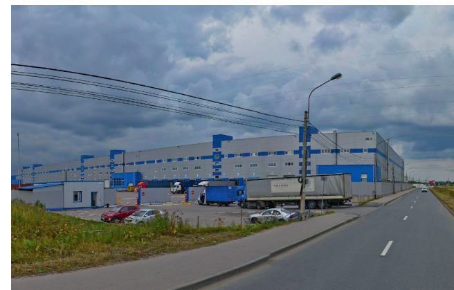
ЭС ЭМ СИ Пневматик, г. Санкт-Петербург Вентиляционные агрегаты
