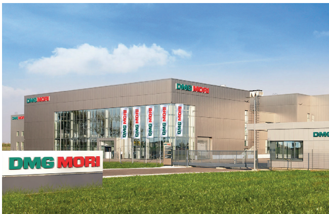
Ульяновский станкостроительный завод DMG Mori, г. Ульяновск Рециркуляционные агрегаты
