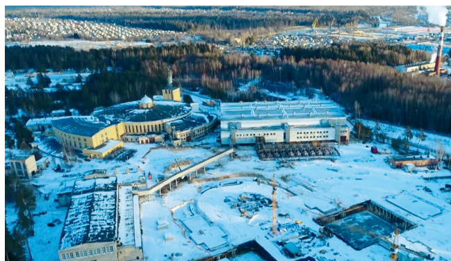
Объединённый институт ядерных исследований (ОИЯИ), Тяжелоионный коллайдер NICA, г. Дубна Прецизионные кондиционеры
