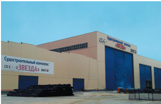
Судостроительный завод «ЗВЕЗДА» г. Владивосток Вентиляционные агрегаты
