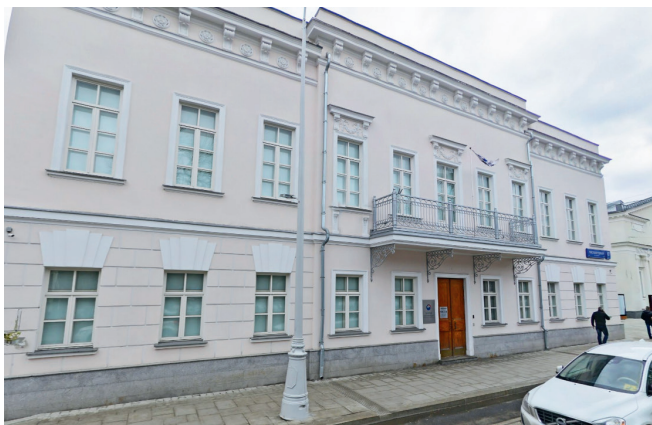
КУЛЬТУРНЫЙ Центр Посольства Республики Корея г. Москва, Чистопрудный бульвар, 17 Мультизональные системы
