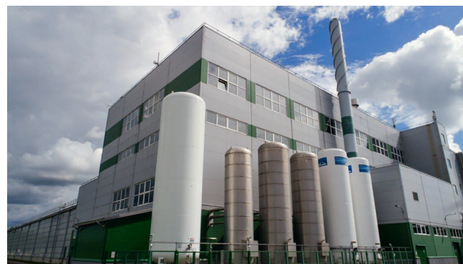
«ЛТ Крес Нева», производственный корпус по производству нетабчных компонентов, Ленинградская область Вентиляционные установки
