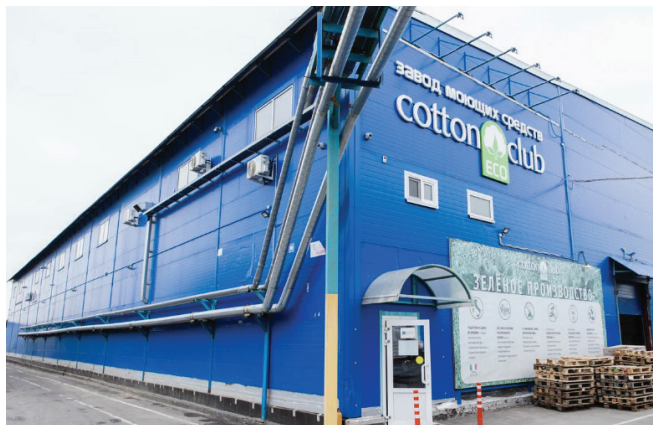
Коттон Клуб (производство средств гигиены), г. Балашиха Модульные чиллеры Dunham-Bush
