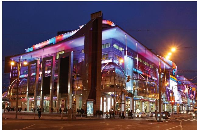
Торгово-Развлекательный центр Европейский, г. Москва Мультизональные системы
