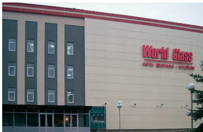
Фитнес-центр World Class, г. Санкт-Петербург Осушители
