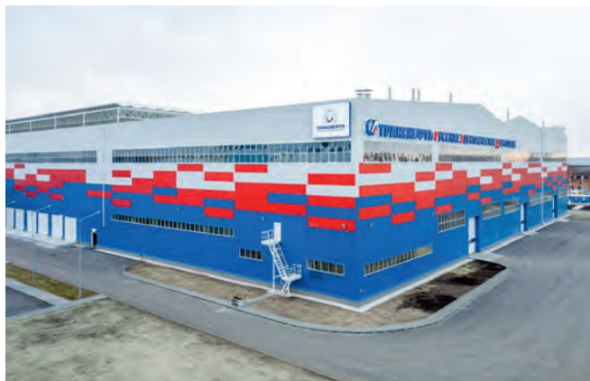
АО «РЭД» Транснефть, г. Челябинск Прецизионные кондиционеры
