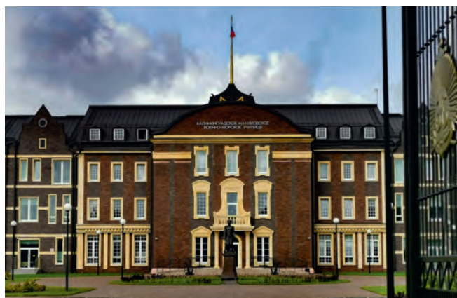
Нахимовское военно-морское училище, г. Калининград Сплит-системы
