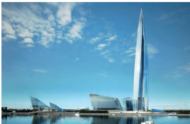
Лахта Центр, г. Санкт-Петербург Фэн-койлы, увлажнители
