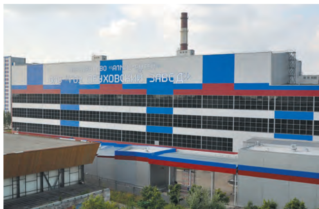
СЗРЦ «Алмаз-Антей», г. Санкт-Петербург Вентиляционные агрегаты
