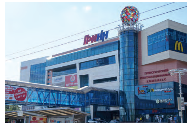
ТЦ «Гринн», г. Орел Сплит-системы
