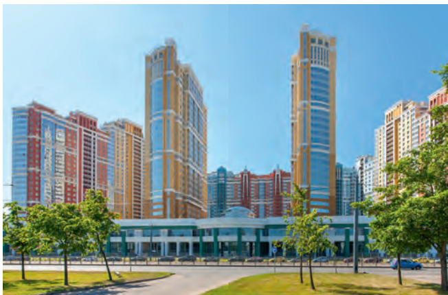
ЖК «Лондон Парк», г. Санкт-Петербург Осушители
