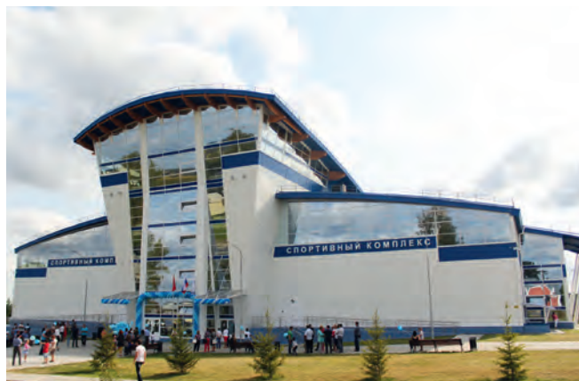
ФОК «Ленинское», Тульская обл. Прецизионные кондиционеры
