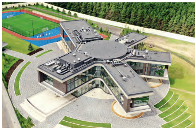
Wunderpark International School, Московская область Рециркуляционные агрегаты
