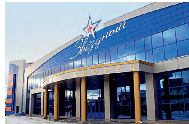
Ледовый дворец «Звёздный» г. Оренбург Вентиляционные агрегаты
