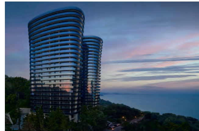
ЖК «Сан Сити», г. Сочи Сплит-системы
