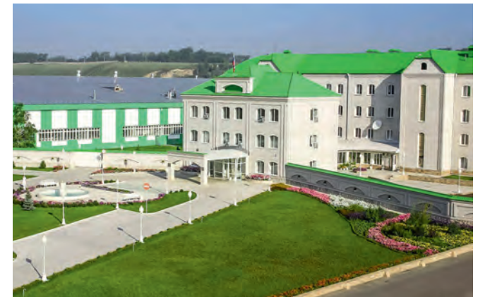
Pharmaceutical plant «Evalar», Biysk Adsorption dehumidifiers Cotes
