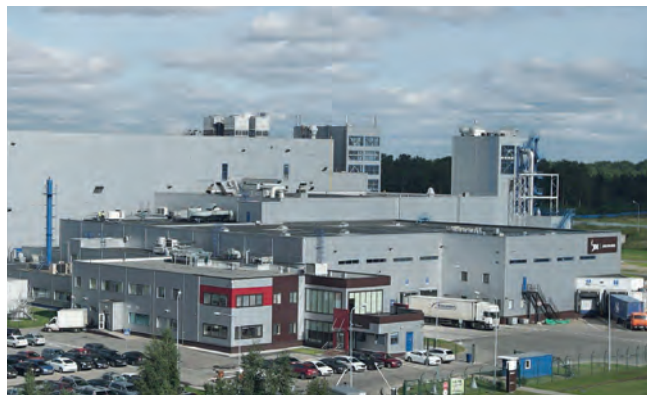
«JACOBS DOUWE EGBERTS RUS» Plant, St. Petersburg Daikin VRV chillers, Refrion Condensers
