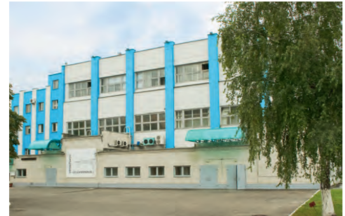
«Veropharm Belgorod» Plant, Belgorod Daikin VRV chillers
