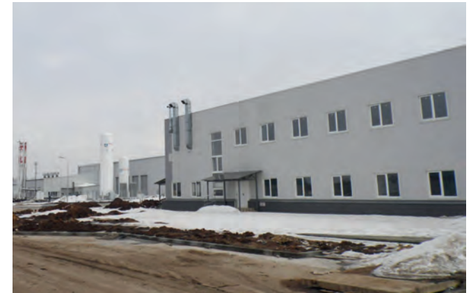
Livestock complex «Tambov bacon», Tambov region Hitachi VRF Set Free
