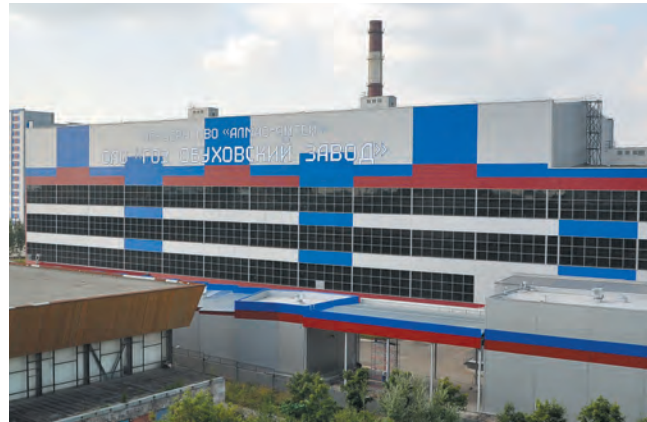
NWRC «Almaz-Antey», St. Petersburg Decentralised ventilation system Hoval
