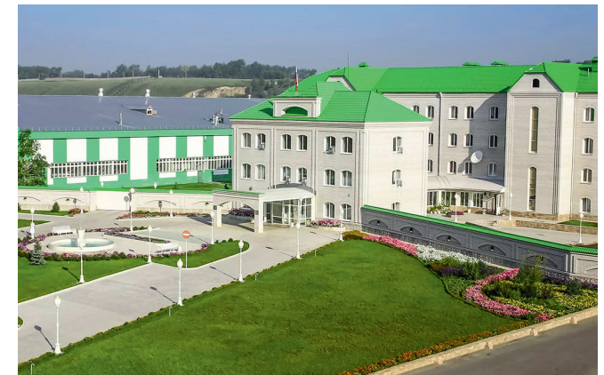
Pharmaceutical plant «Evalar», Biysk Adsorption dehumidifiers Cotes
