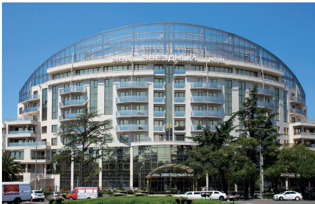
Spa Hotel «Zvezdnyy», Sochi Air supply units Dantherm DanX 16/32
