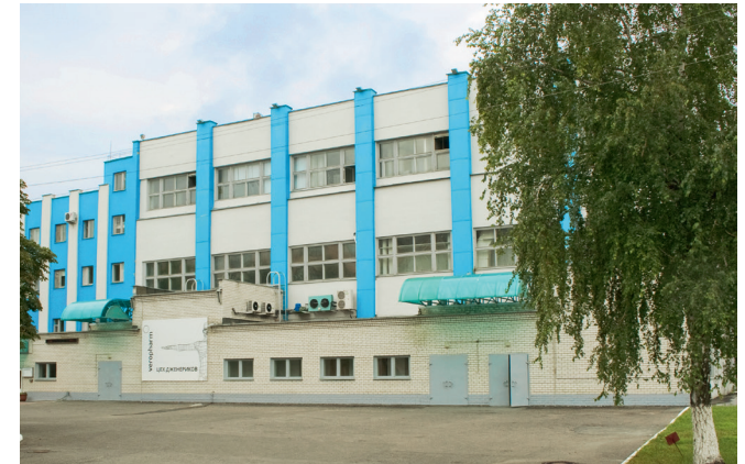
«Veropharm Belgorod» Plant, Belgorod Daikin VRV chillers
