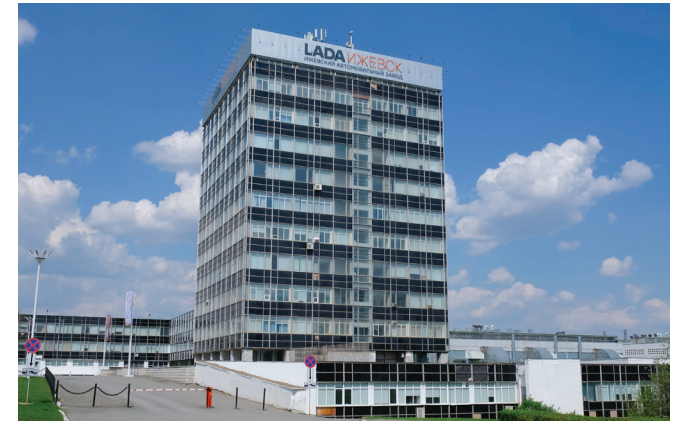
Automobile factory «LADA», Izhevsk Daikin VRV chillers
