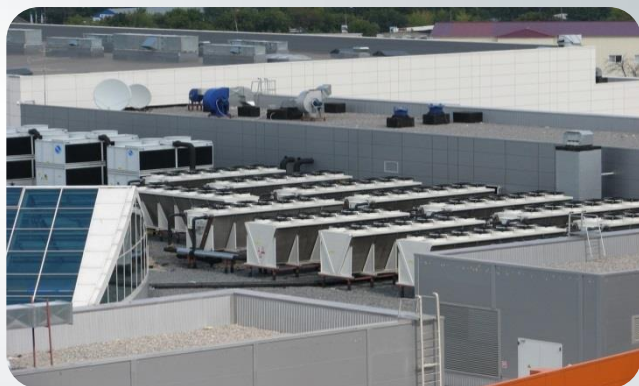
Торгово-деловой центр «Метрополис», г. Москва
