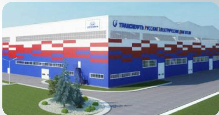
АО «РЭД» Транснефть, г. Челябинск
