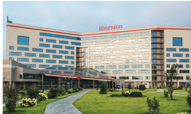
Отель Sheraton г. Москва VRV, вентиляционные установки для бассейна
