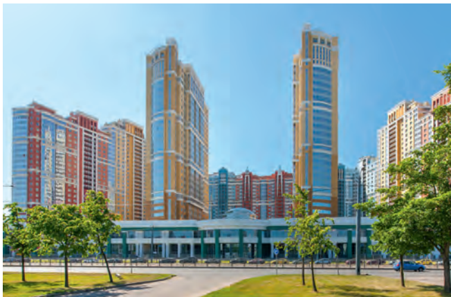
ЖК «Лондон Парк», г. Санкт-Петербург Осушители
