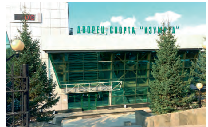
Бассейн «Изумруд» г. Иркутск Вентиляционные установки для бассейна
