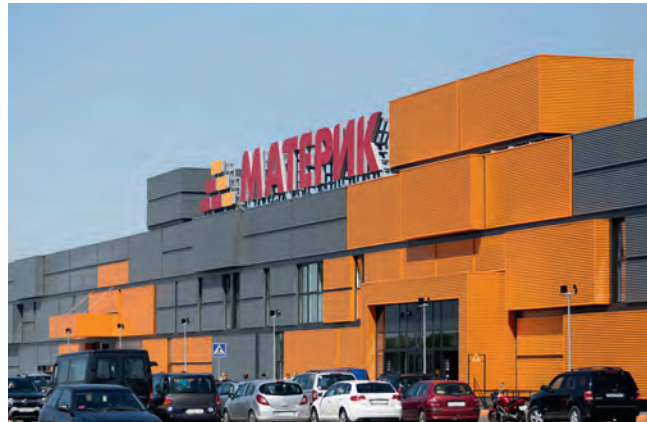
Гипермаркет строительных материалов «Материк», республика Беларусь Вентиляционные агрегаты
