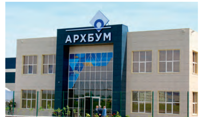
Производственные и складские помещения компании «Архбум», Калужская обл. и Московская обл. Вентиляционные агрегаты
