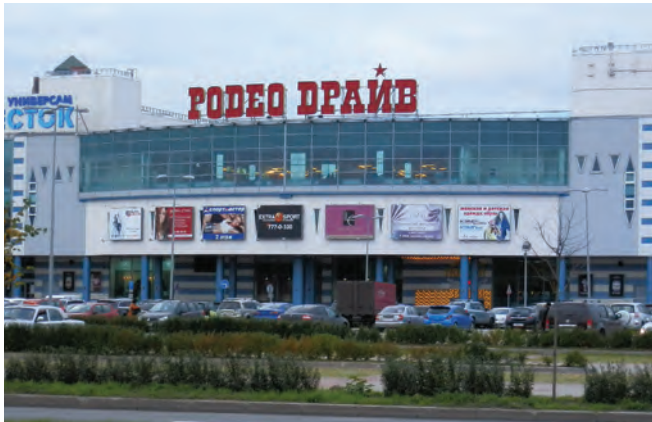
Аквапарк «Родео Драйв», г. Санкт-Петербург Вентиляционные установки для бассейна
