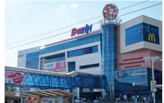
ТЦ «Гринн», г. Орел Сплит-системы
