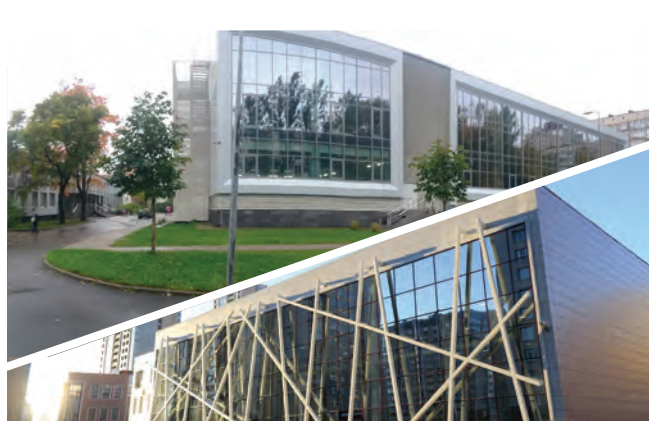
ГБОУ СОШ №305, 777 г. Санкт-Петербург Вентиляционные установки для бассейна
