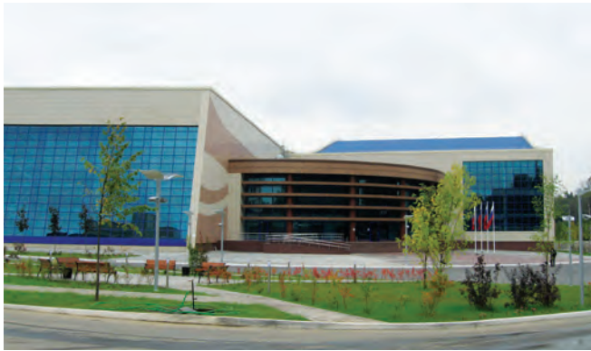
Спортивный комплекс «Озеро Круглое», Московская обл. Вентиляционные установки для бассейна Вихревые воздухораспределители
