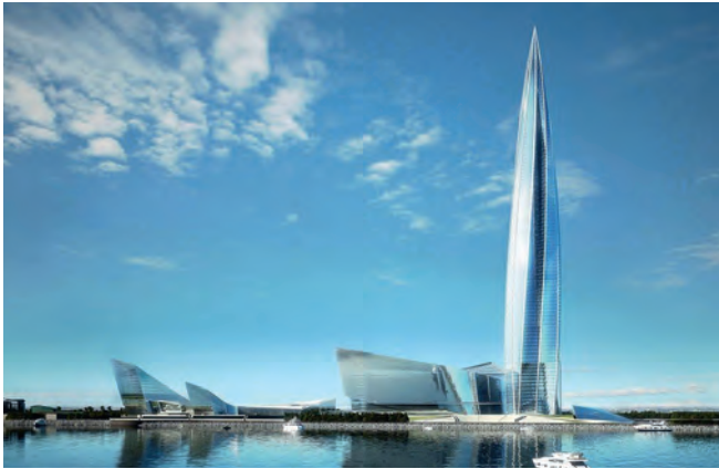
Лахта Центр, г. Санкт-Петербург Фэн-койлы, увлажнители
