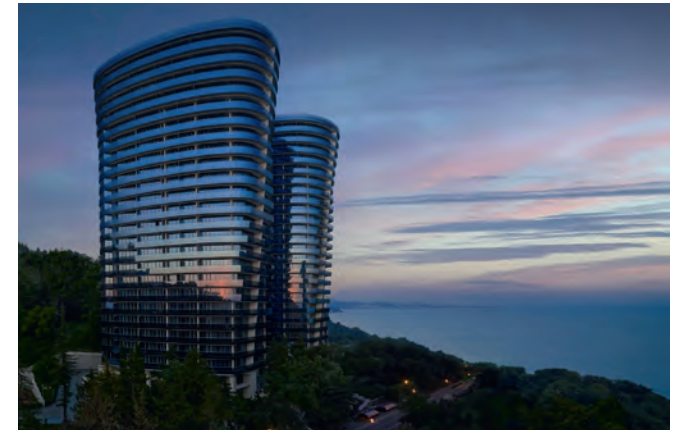
ЖК «Сан Сити», г. Сочи Сплит-системы
