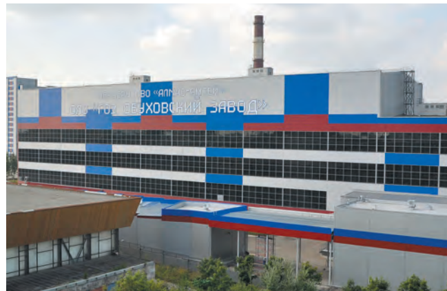
СЗРЦ «Алмаз-Антей», г. Санкт-Петербург Вентиляционные агрегаты
