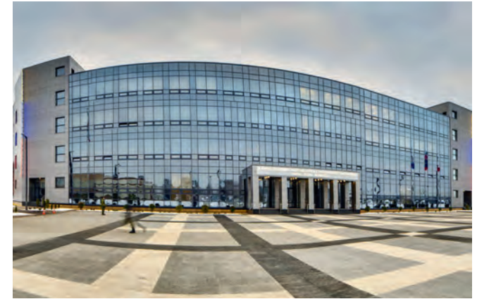
Военная Академия РВСН им. Петра Великого, Московская обл., г. Балашиха VRF Set Free
