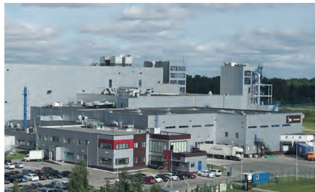
Завод «ЯКОБС ДАУ ЭГБЕРТС РУС», г. Санкт-Петербург VRV чиллеры Конденсаторы
