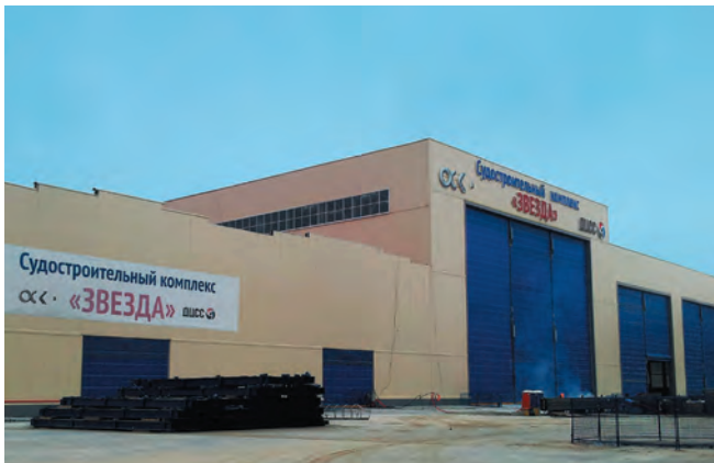
Судостроительный завод «ЗВЕЗДА» г. Владивосток Вентиляционные агрегаты
