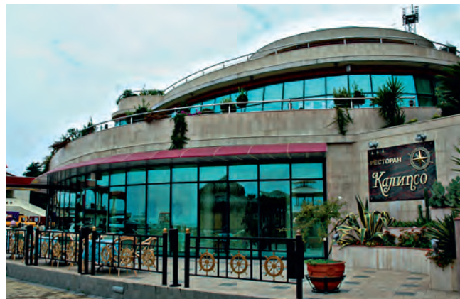
Ресторан «Калипсо» г. Сочи Вентиляционные установки для бассейна
