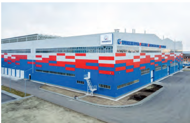
АО «РЭД» Транснефть, г. Челябинск Прецизионные кондиционеры
