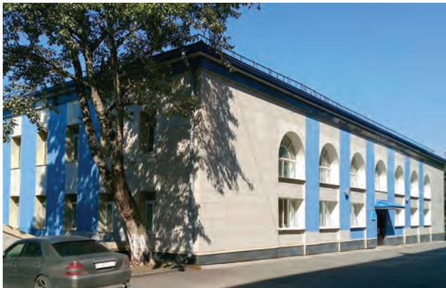
Бассейн «Морского Государственного университета им. адм. Г.И. Невельского», г. Владивосток Вентиляционные установки для бассейна
