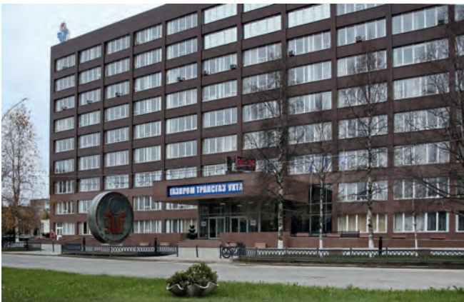
Административное здание ООО «Газпром трансгаз Ухта», г. Ухта VRV
