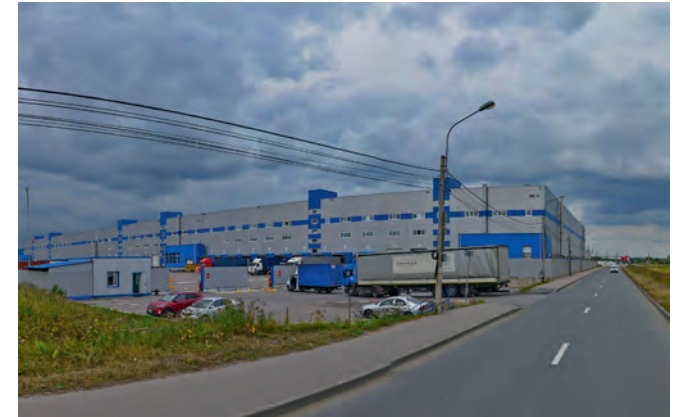
ЭС ЭМ СИ Пневматик, г. Санкт-Петербург Вентиляционные агрегаты
