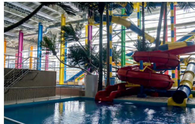
Аквапарк, г. Южно-Сахалинск Вентиляционные установки для бассейна
