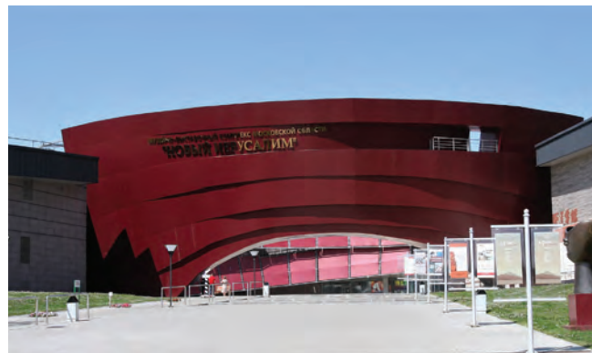
Музейно-выставочный комплекс «Новый Иерусалим» г. Истра, Московская обл., Мобильные осушители
