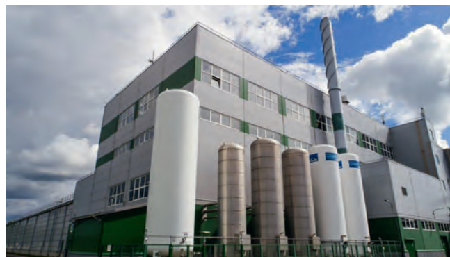
«ЛТИ Крес Нева», производственный корпус по производству нетабачных компонентов, Ленинградская область АНУ, суммарный расход 81 000 м³/ч
