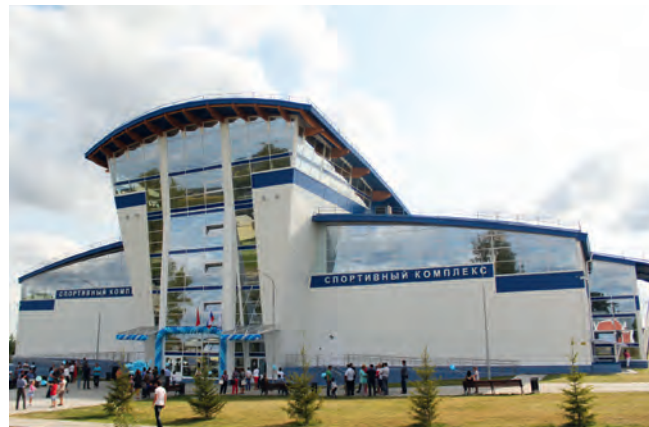
ФОК «Ленинское», Тульская обл. Прецизионные кондиционеры
