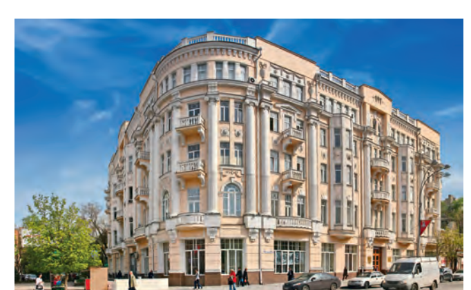
Южный Федеральный Университет г. Ростов-на-Дону Вентиляционные установки для бассейна
