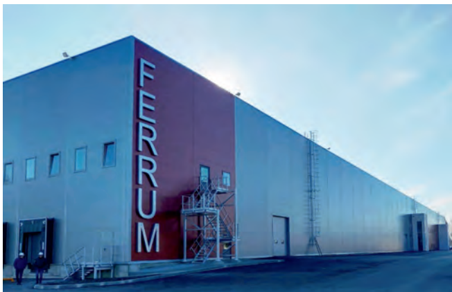
Завод металлоконструкций Ferrum, г. Воронеж Рециркуляционные агрегаты
