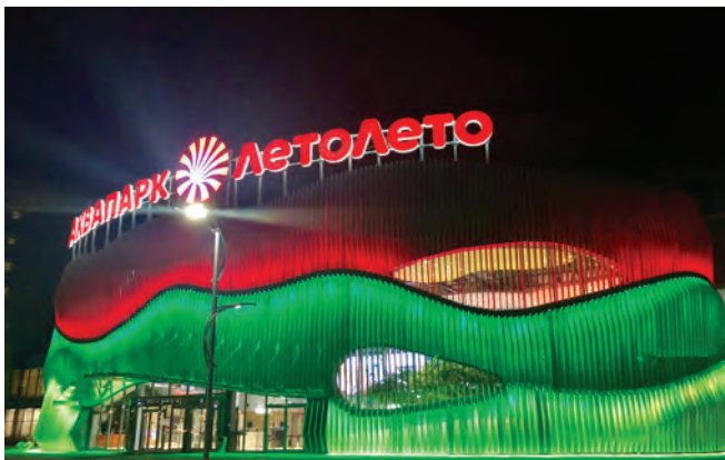
Аквапарк «ЛетоЛето», г. Тюмень Вентиляционные установки для бассейна
