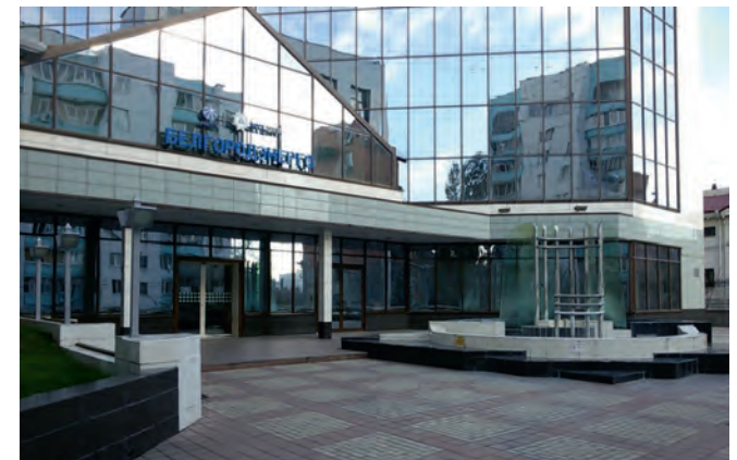
Административное Здание Центра управления се- тями МРСК Центра «Белгородэнерго», г. Белгород VRF Set Free
