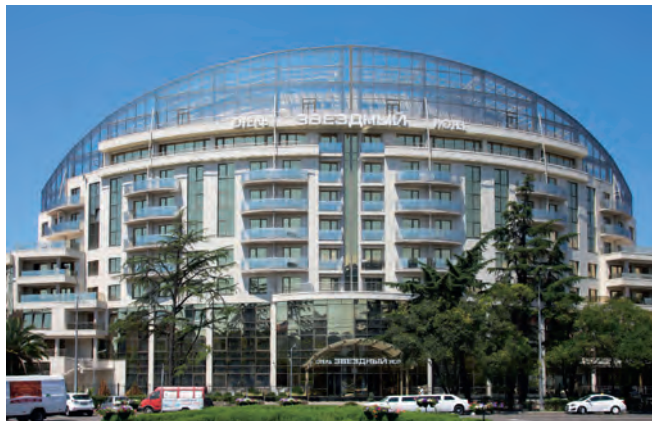
СПА-отель «Звездный» г. Сочи Вентиляционные установки для бассейна
