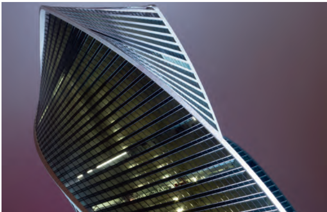
Офис Транснефть, Москва Сити, башня Эволюция, г. Москва Осушители VRF Set Free
