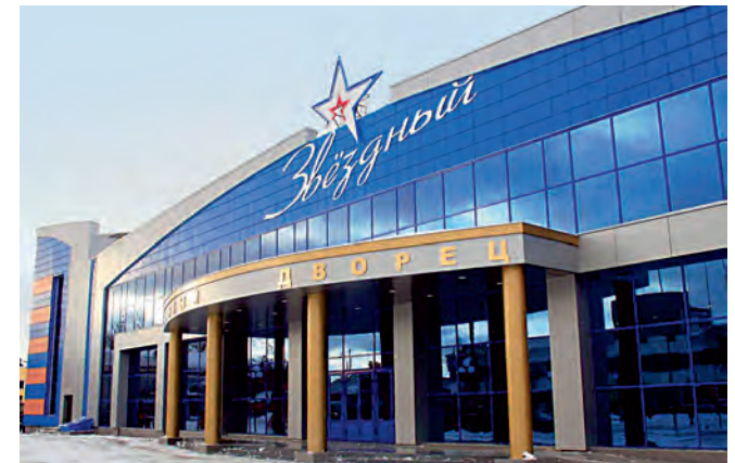
Ледовый дворец «Звёздный» г. Оренбург Вентиляционные агрегаты
