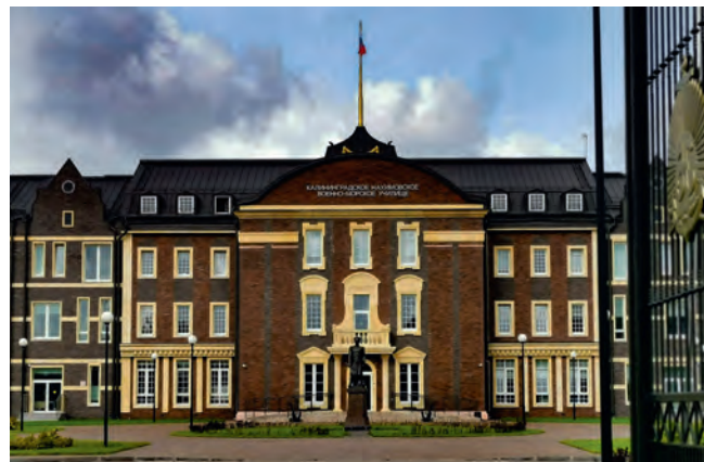
Нахимовское военно-морское училище, г. Калининград Сплит-системы
