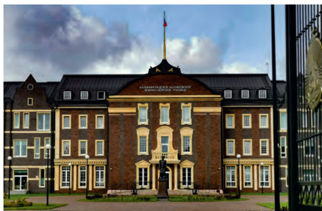
Нахимовское военно-морское училище, г. Калининград Сплит-системы Daikin, Pioneer
