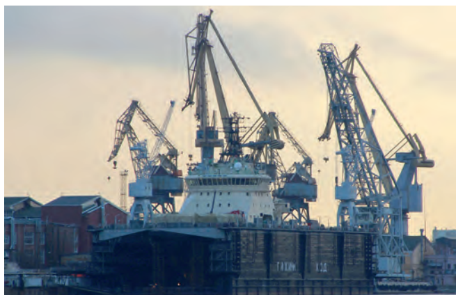
Адмиралтейские верфи, г. Санкт-Петербург Вентиляционные агрегаты Noval
