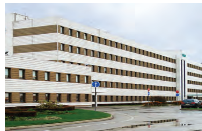
Складской комплекс «Петро», г. Санкт-Петербург Рециркуляционные агрегаты Noval
