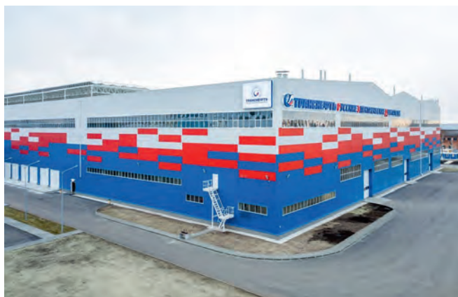
АО «РЭД» Транснефть, г. Челябинск Прецизионные кондиционеры TECNAIR LV
