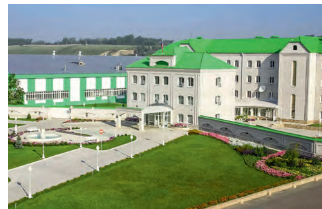
Фармацевтический завод «Эвалар», г. Бийск Адсорбционные осушители Cotes
