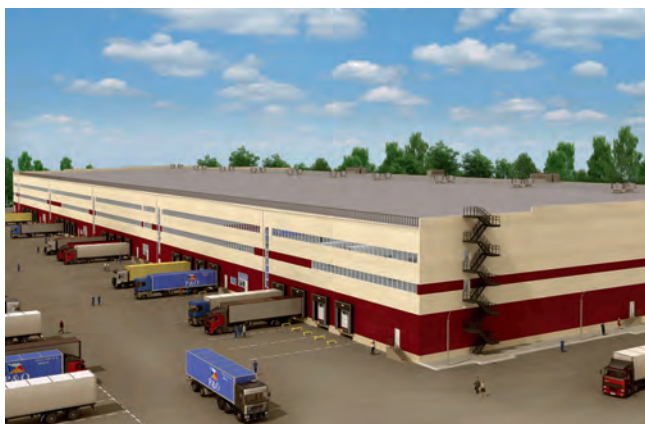
Складской комплекс «Аэробус», г. Воронеж Рециркуляционные агрегаты Noval
