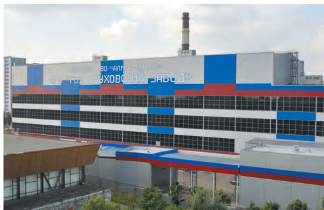
СЗРЦ «Алмаз-Антей», Санкт-Петербург Вентиляционные агрегаты Noval
