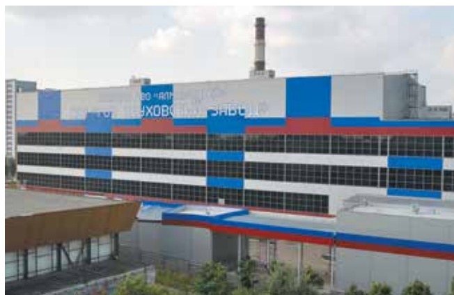
СЗРЦ «Алмаз-Антей», Санкт-Петербург Вентиляционные агрегаты Noval
