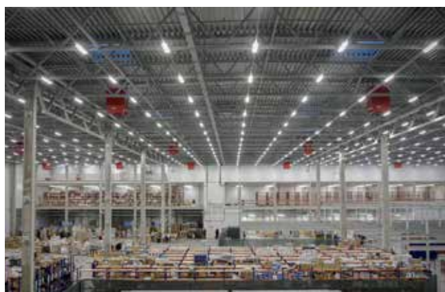
Складские помещения компании «Юлмарт», Санкт-Петербург Рециркуляционные агрегаты Noval
