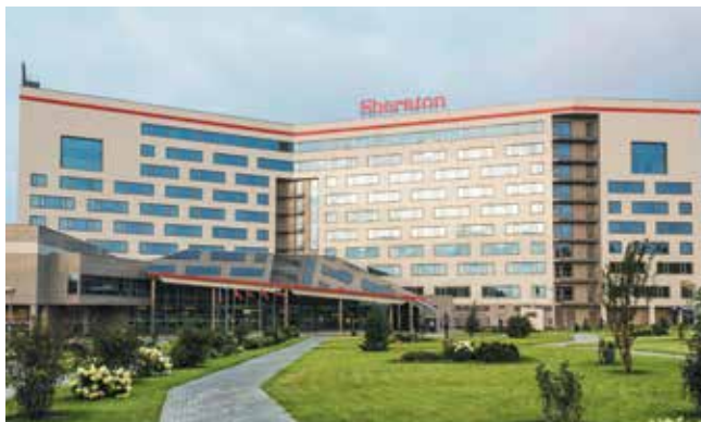
Отель Sheraton г. Москва Daikin VRV, вентиляционные агрегаты Dantherm DanX 7/14
