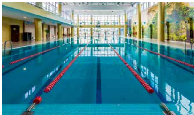
Фитнес-клуб Taurus Fitness, Санкт-Петербург Вентиляционные агрегаты Dantherm DanX 7/14 XWP
