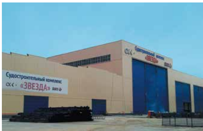
Судостроительный завод «ЗВЕЗДА» г. Владивосток Вентиляционные агрегаты Noval
