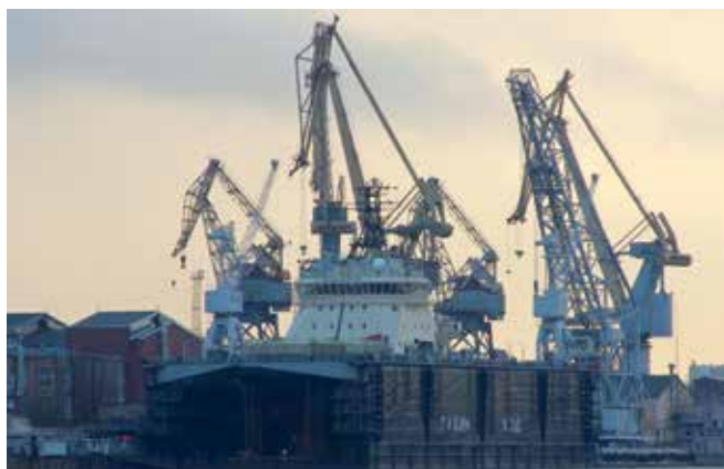
Адмиралтейские верфи, Санкт-Петербург Вентиляционные агрегаты Noval
