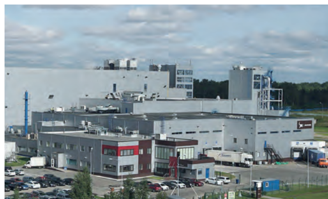
Завод «ЯКОБС ДАУ ЭГБЕРТС РУС», Санкт-Петербург Daikin VRV чиллеры Конденсаторы Refrion
