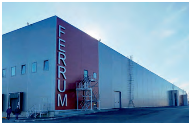
Завод металлоконструкций Ferrum, г. Воронеж Рециркуляционные агрегаты Noval
