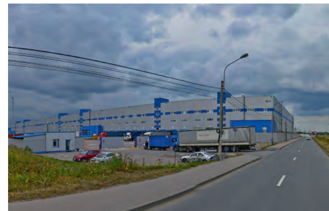
ЭС ЭМ СИ Пневматик, Санкт-Петербург Вентиляционные агрегаты Noval
