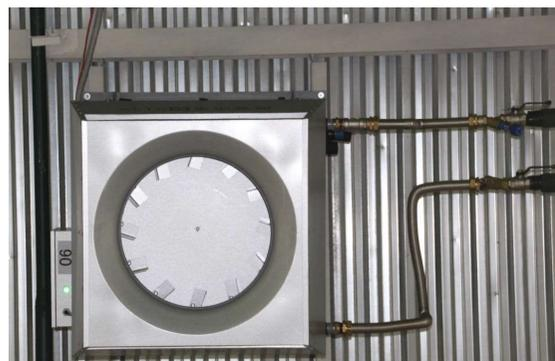
Рециркуляционный агрегат для обогрева и охлаждения помещений с высокими потолками
